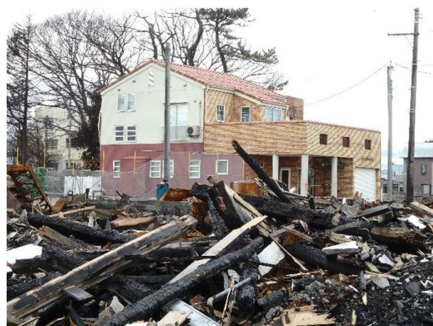
周囲が焼失したにもかかわらず、ほぼ無傷だった「奇跡の木造住宅」と報道された住宅です。火に強いステンレスのトタン板を外壁に使い、屋根の軒先は火の粉が入りにくい設計としたなど、防災特別仕様だったとのこと。改めて災害に強い家作りの重要性を痛感しました。
